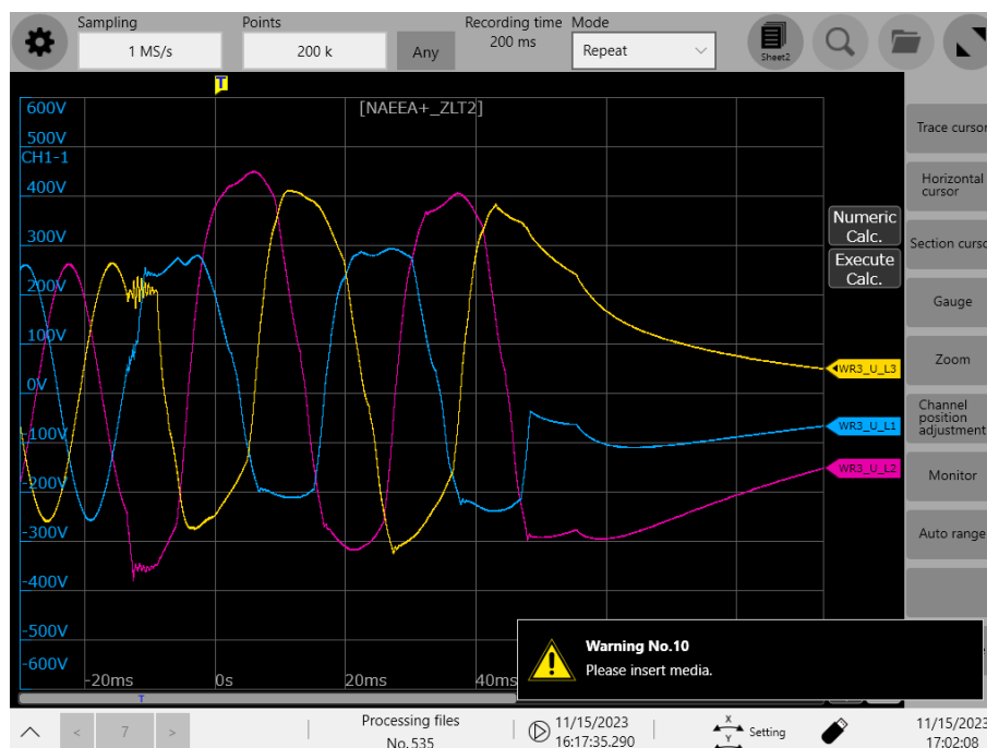
Abbildung 5.2-15: Osilloskop-Aufnahme der Ausgangsspannungen von Wechselrichter 2 nach der Trennung vom Netz durch den externen NA-Schutz
