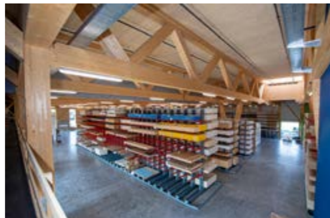
Durch den Einsatz von Holz entzieht der neue Verkaufs- und Logistikstandort der KURATLE & JAECKER in Märstetten der Atmosphäre 3427 Tonnen CO 2 .
