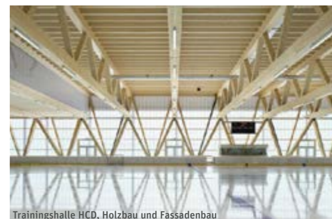
Trainingshalle HCD, Holzbau und Fassadenbau
