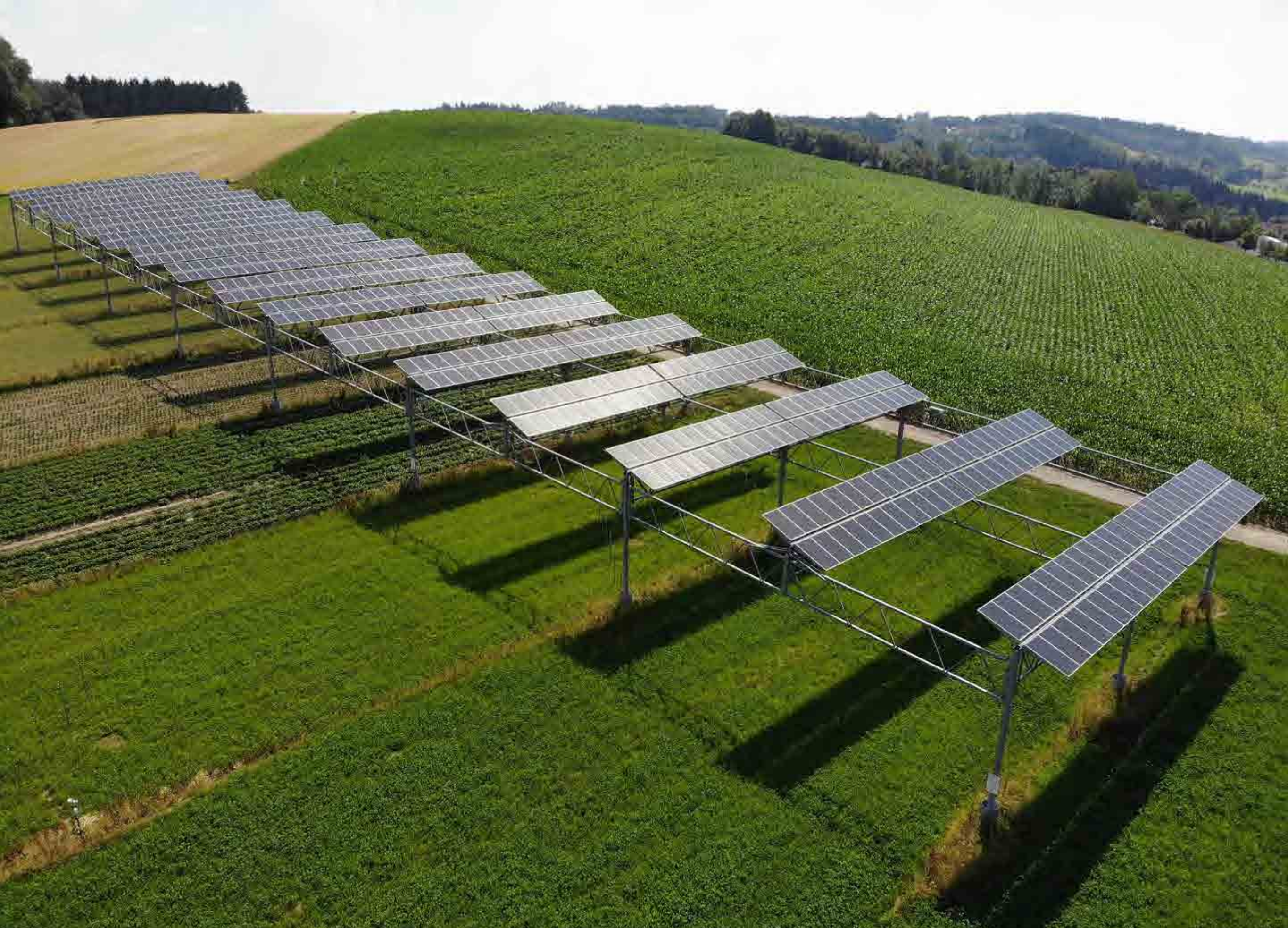
Agrophotovoltaik (APV) Forschungsanlage des Fraunhofer ISE am Bodensee
