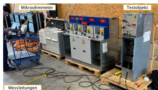
Abbildung 1: Versuchsdurchführung Siemens 8DJH, BKW Standort Luterbach SO
