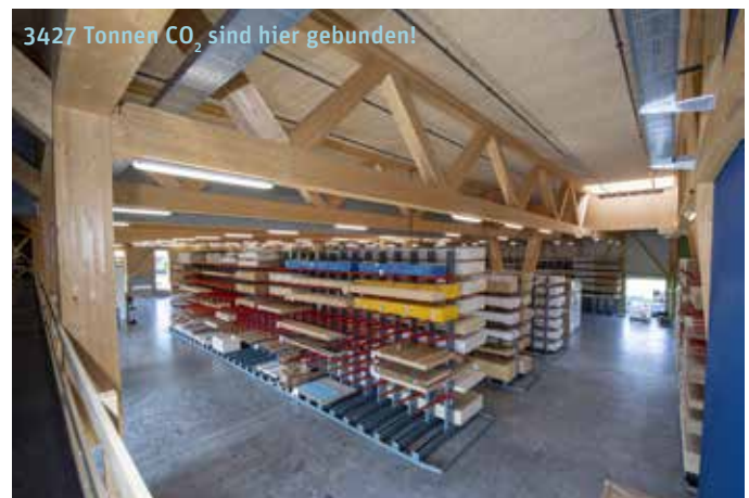
Logistik- und Auslieferungslager in Märstetten
