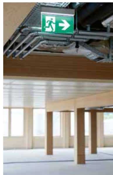
Überbauung «Suurstoffi» in Rothrist (vgl. TEC21 20/2013): Brandschutz bei mehrstöckigen Holzbauten praktisch angewandt.
