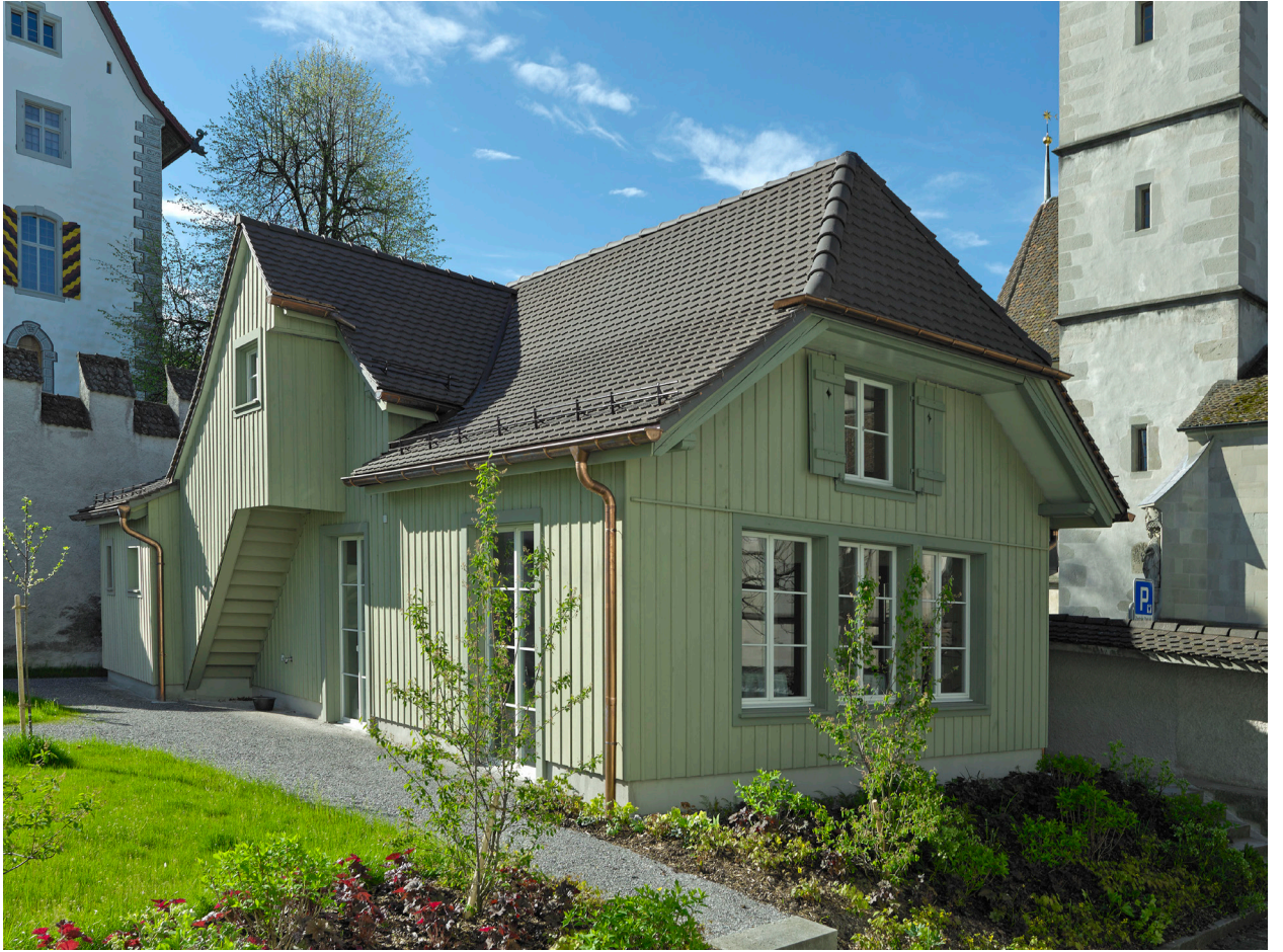
Abb. 4: Bauhütte St. Oswaldskirche nach dem Umbau, 2018
