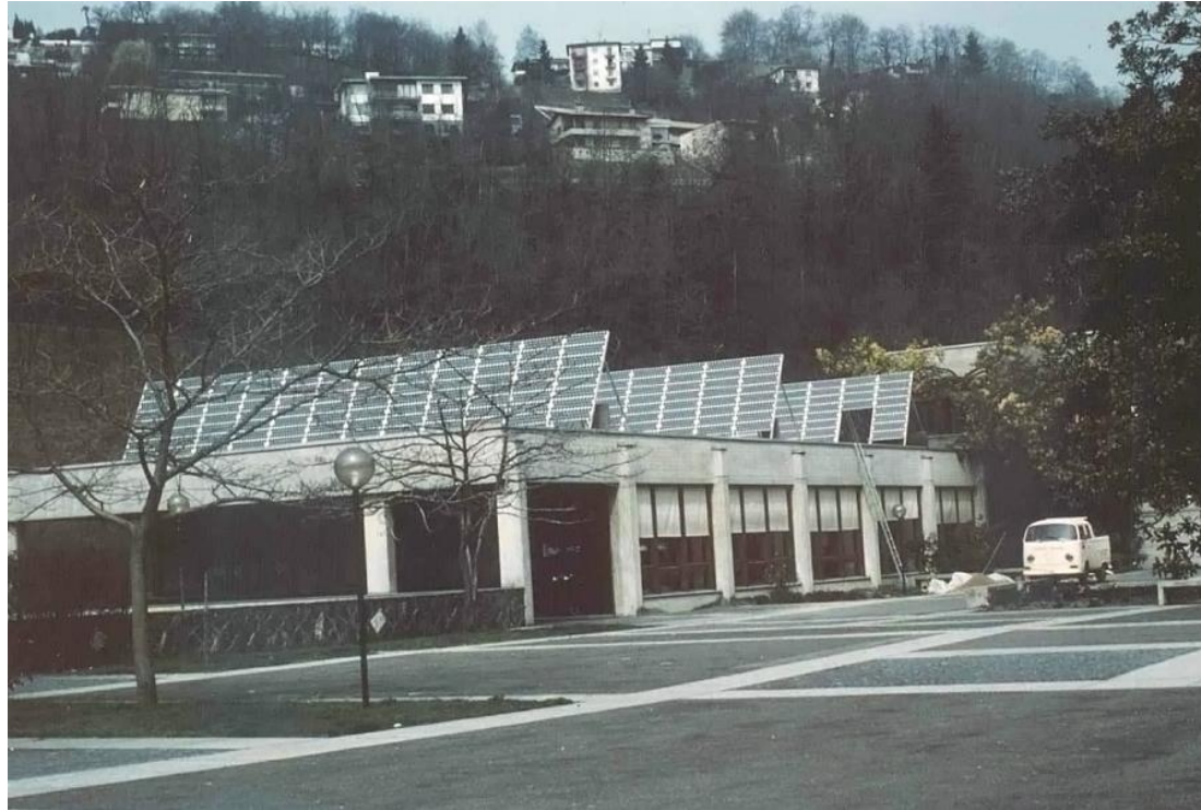
TISO-10 (Ticino SOLare): 10,6 kWp / ARCO-Solar-Module: 37 W, \eta = 10\% / 28.5 Franken pro installiertes Watt. (Quelle: SUPSI)
