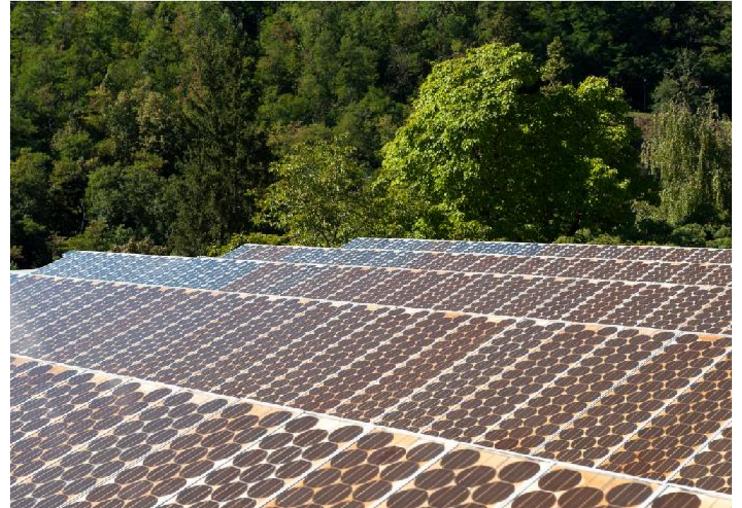
TISO-10 (Ticino SOLare): 10,6 kWp / ARCO-Solar-Module: 37 W, \eta = 10\% / 28.5 Franken pro installiertes Watt. (Quelle: SUPSI)
